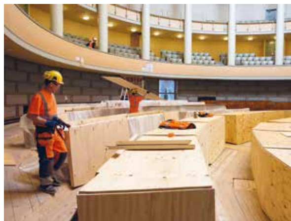
Täysistuntosalin kiinteät pulpetit suojataan vanerilla peruskorjauksen ajaksi.
