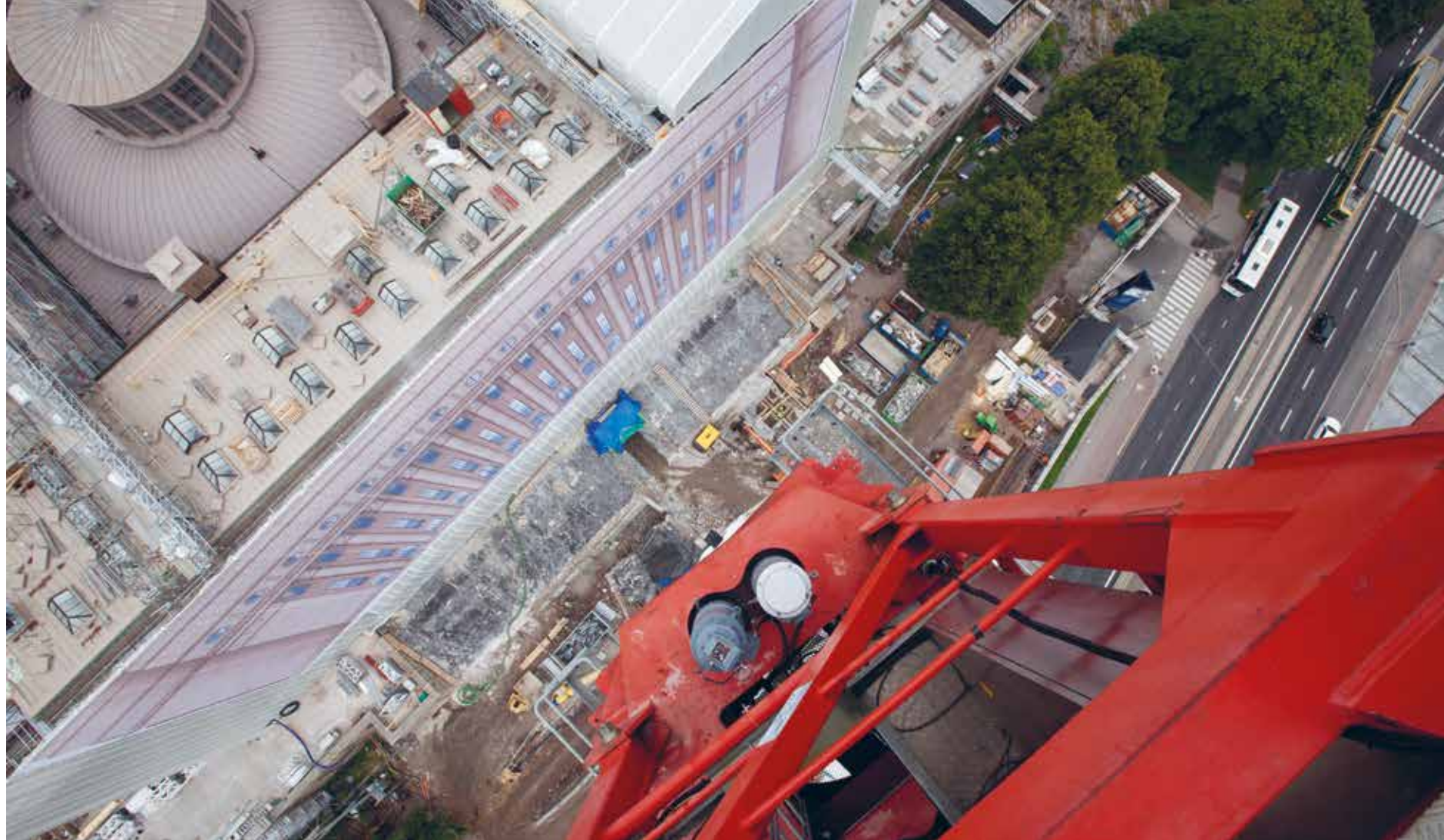
Peruskorjaustyömaata hallitsee kaksi nosturia. Eduskuntatalon eteen pystytetyn nosturin korkeus on 74,7 metriä (85,4 metriä merenpinnasta).
