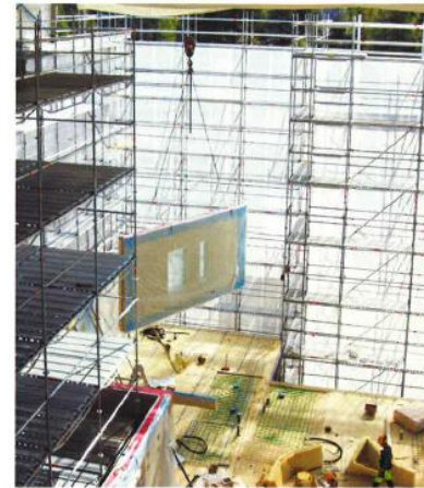
Kuva 1. Rakentaminen voidaan tehdä myös säästä suojassa.
