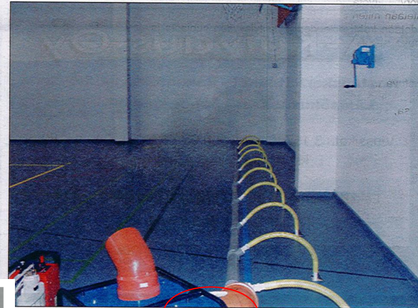
Lattiarakenteen desinfiointi menossa.
