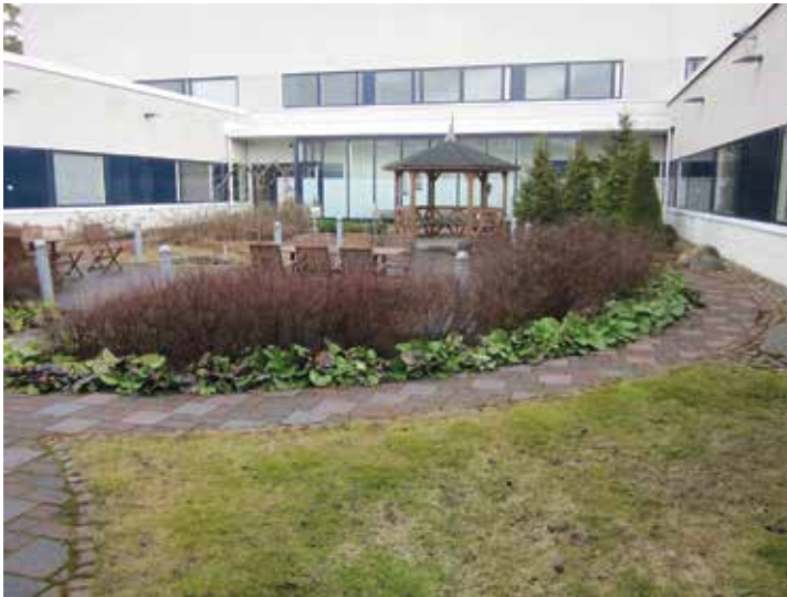
Vammalan sairaalan sisäpiha, jossa psykiatrian potilaat voivat itsenäisesti ulkoilla (tarkastus 19.4.2016).
